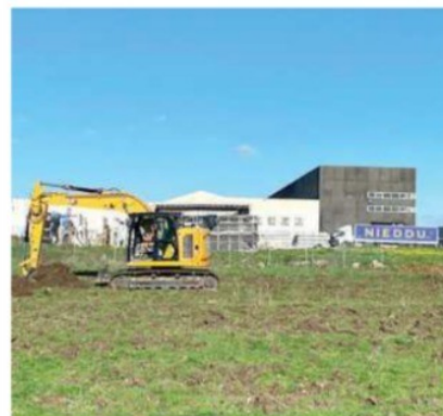
I lavori all'esterno della Nobento che porteranno alla realizzazione delle nuove strutture che daranno vita alla Cittadella del serramento
